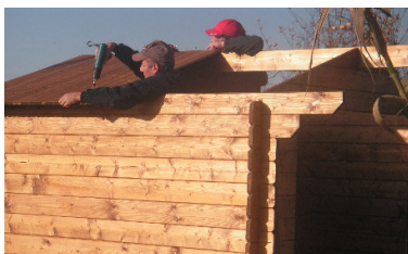
Construction de notre cabane de jardin
